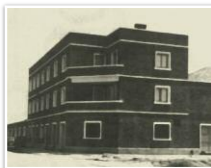
Primera construcción en 1959
